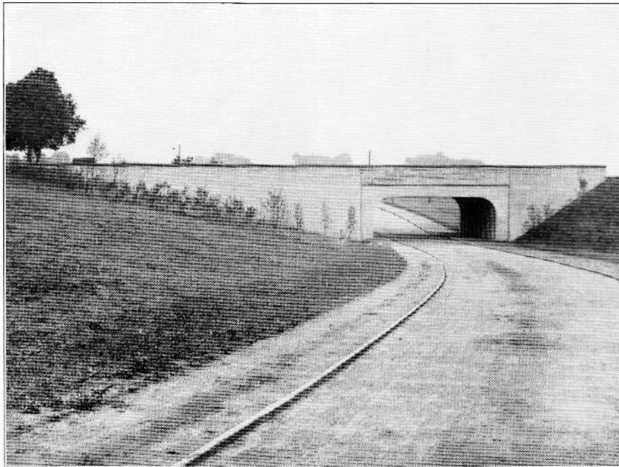
Bild 15 Eingespannter Rahmen als Brücke für die Unterführung des Grüngürtelweges
