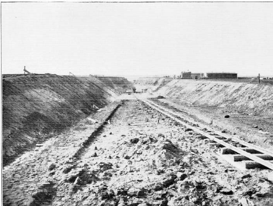
Bild 5 Einschnitt für die Unterführung der Mühlenstr.
